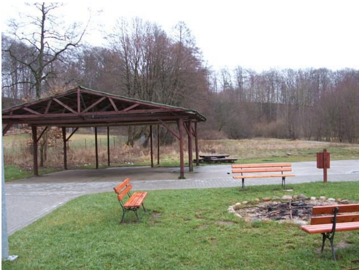
Rycina 26. Istniejąca wiata przeznaczona do rozbiórki wraz z placem betonowym. Źródło: dokumentacja projektowa.
