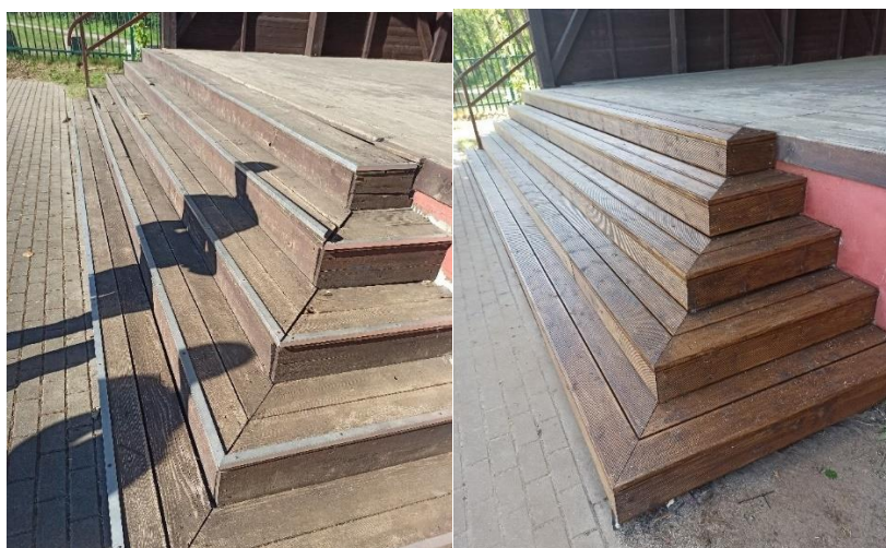
Wyremontowane schody przy wiacie scenicznej w Kobylnicy – przed i po naprawie.
