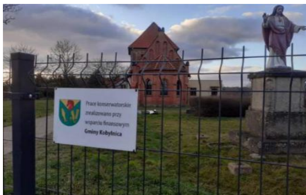
Ogrodzenie w Kościele p.w. Wniebowzięcia NMP w Sierakowie
