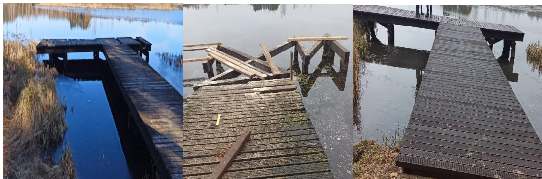
Pomost w Zbyszewie – przed, w trakcie remontu i po realizacji inwestycji.
