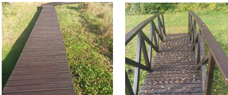
Odnowiona kładka w Reblinie i mostek w Zębowie
