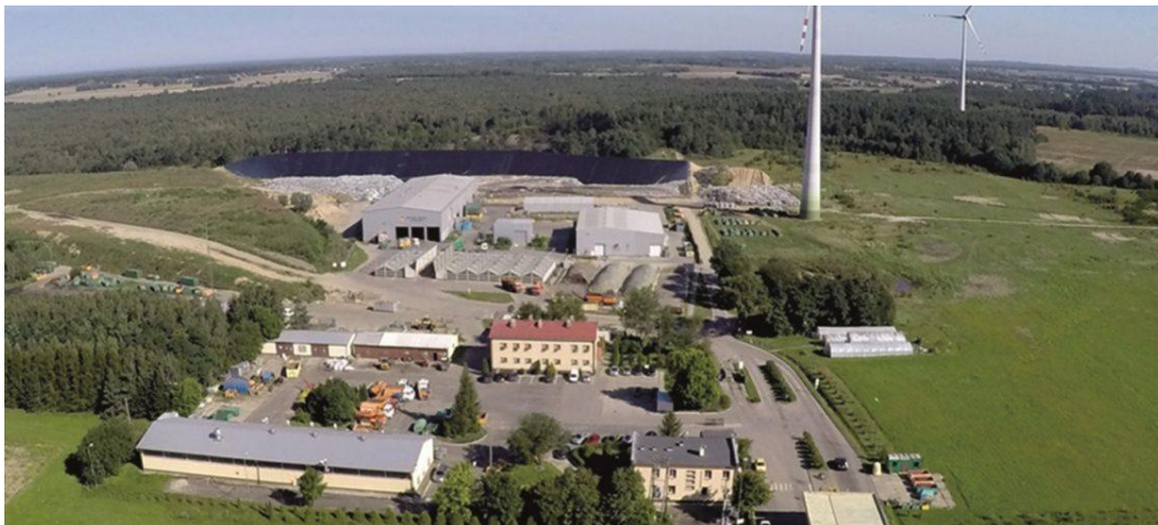
Zdjęcie 2: Rozmieszczenie budynków i składowiska odpadów zlokalizowanych na terenie Zakładu Unieszkodliwiania Odpadów w Słupsku
